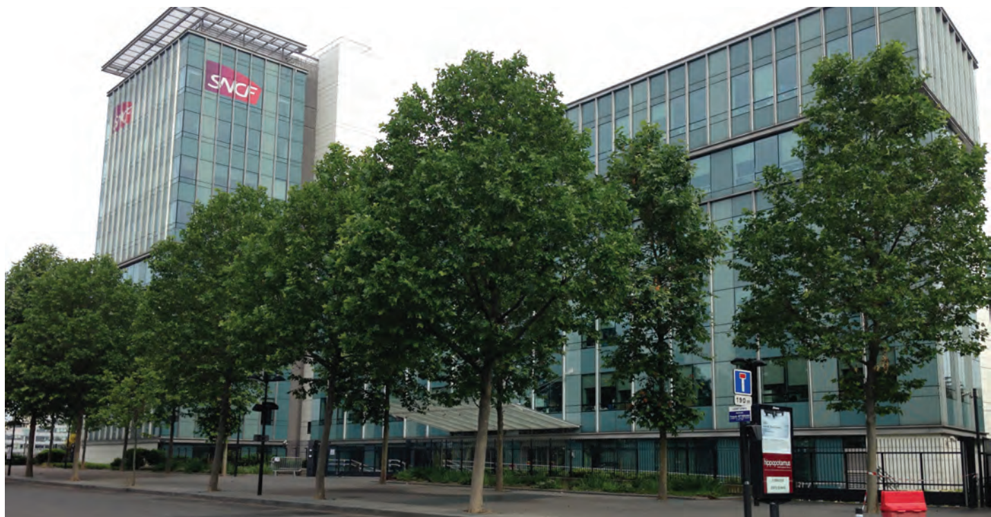
Saint-Denis, La Plaine - bureaux du siège SNCF ©Atile
